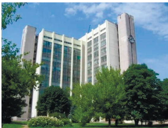
Рис. 1. Здание ОАО «МНИПИ»
